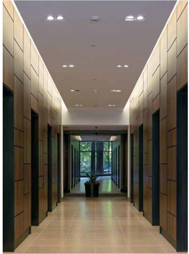
Modernisierte Aufzuganlagen auf technisch neuestem Stand
