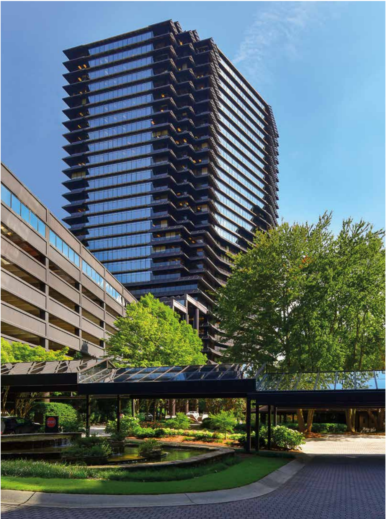
Durch ein besucherfreundliches Verkehrskonzept gelangt man trockenen Fußes vom Parkhaus in die elegante Eingangshalle und alle Gebäudeteile
